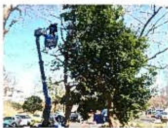
高所作業車による枝処理
