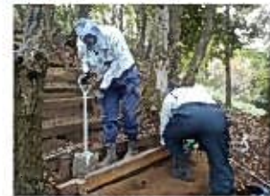
園内発生材を活用した小破修繕
