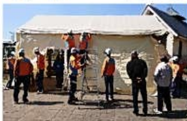
防災パーゴラの設営
