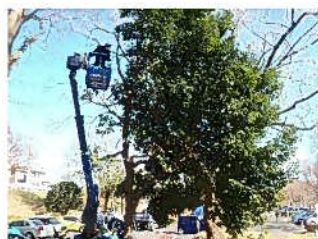
高所作業車による枝処理
