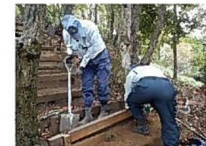
園内発生材を活用した小破修繕
