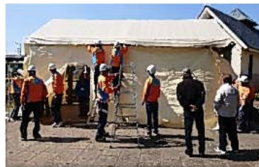
防災パーゴラの設営
