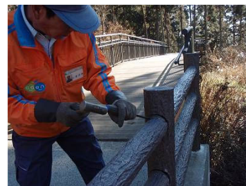
デッキ園路の点検
