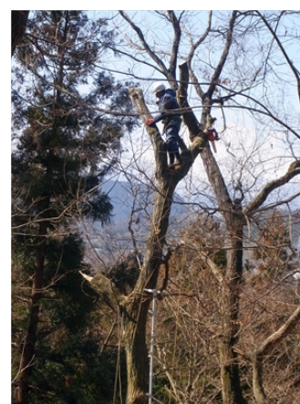
業者委託による 危険木伐採
