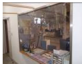
透明板設置 (情報センター受付窓口)
