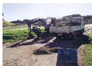
越流後の堆積土の除去作業
