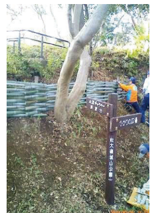
間伐竹を使ったシガラ設置
