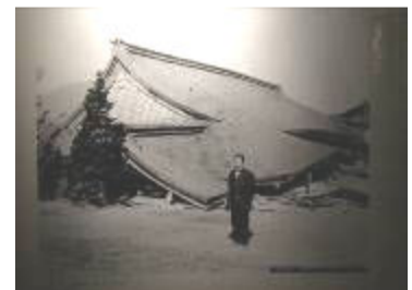
北伊豆地震によって倒壊した離宮の日本館
