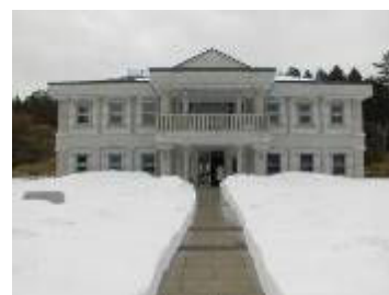
迅速に除雪作業を行います
