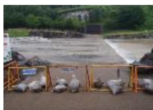
河川への立入禁止措置
