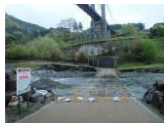
通行止めの措置
