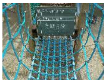
定期点検②
