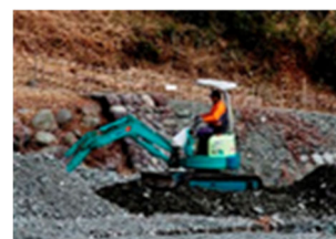
土砂撤去作業
