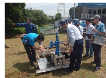
防災設備の作動確認
