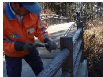
デッキ園路の点検
