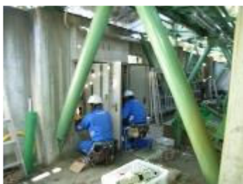
専門業者による点検作業①
