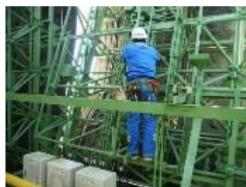
専門業者による点検作業②
