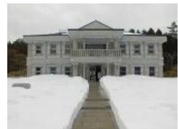
迅速に除雪作業を行います
