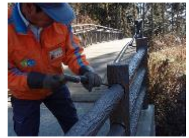
デッキ園路の点検
