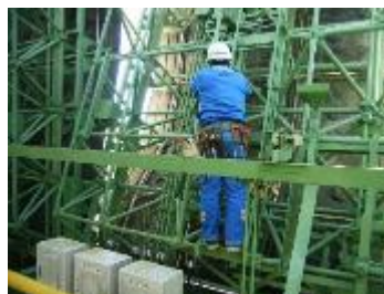
専門業者による点検作業②
