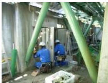
専門業者による点検作業①
