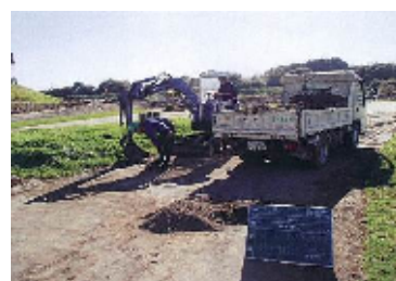
越流後の堆積土の除去作業
