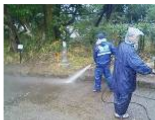
園路の高圧洗浄
