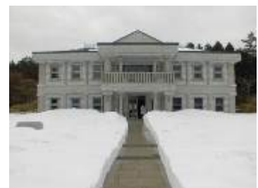
迅速に除雪作業を行います
