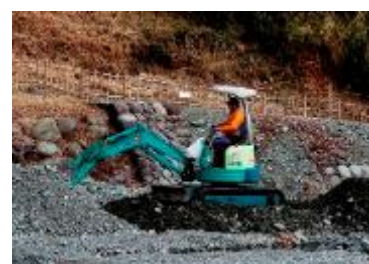
土砂撤去作業
